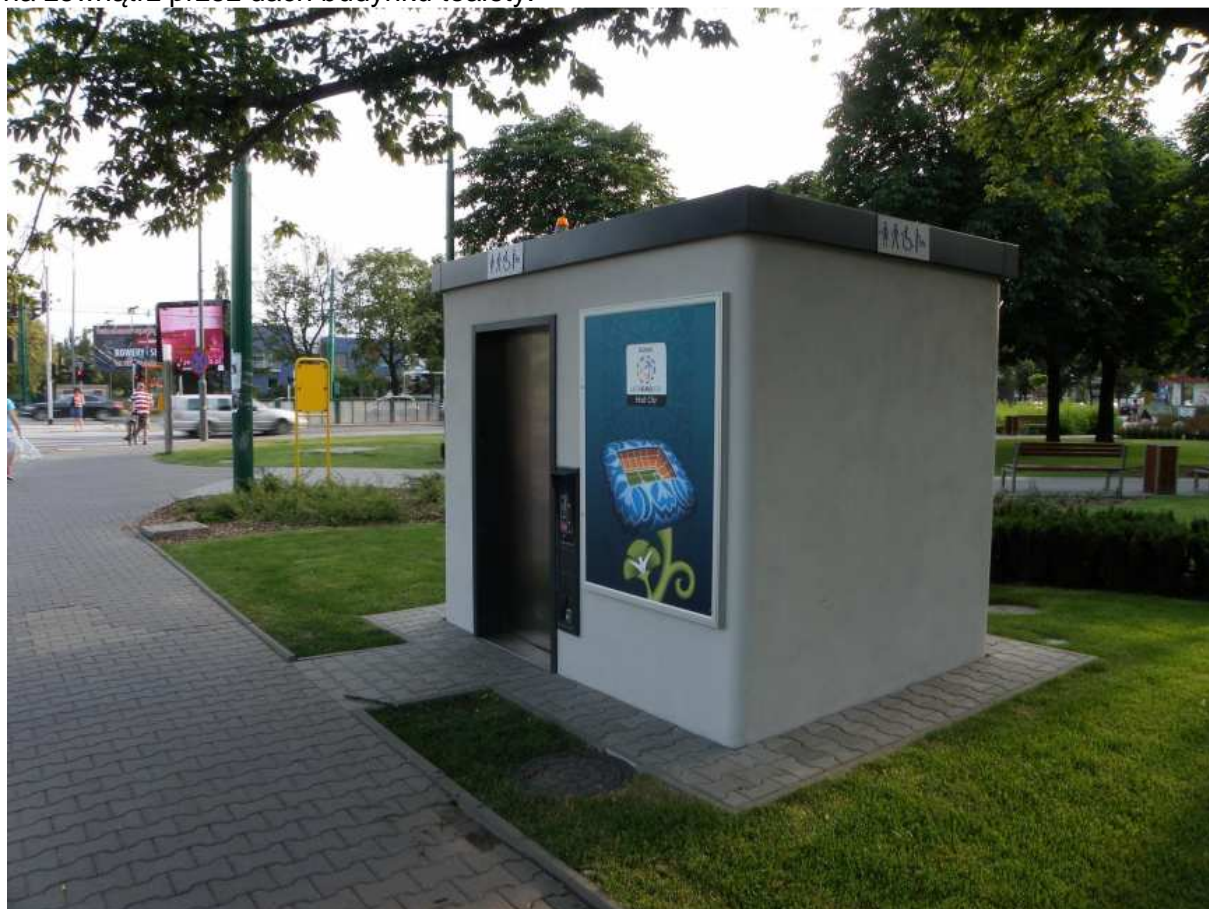
Rys. Przykładowa automatyczna toaleta np. prod. Linea Citta zrealizowana w Poznaniu
