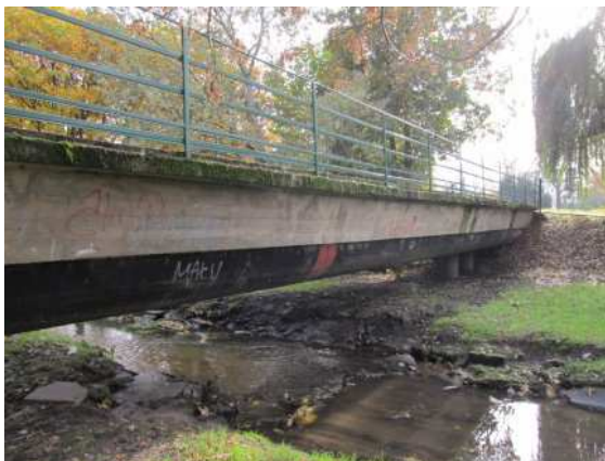
Fot. 2 kładka piesza nr 1 od strony zachodniej
